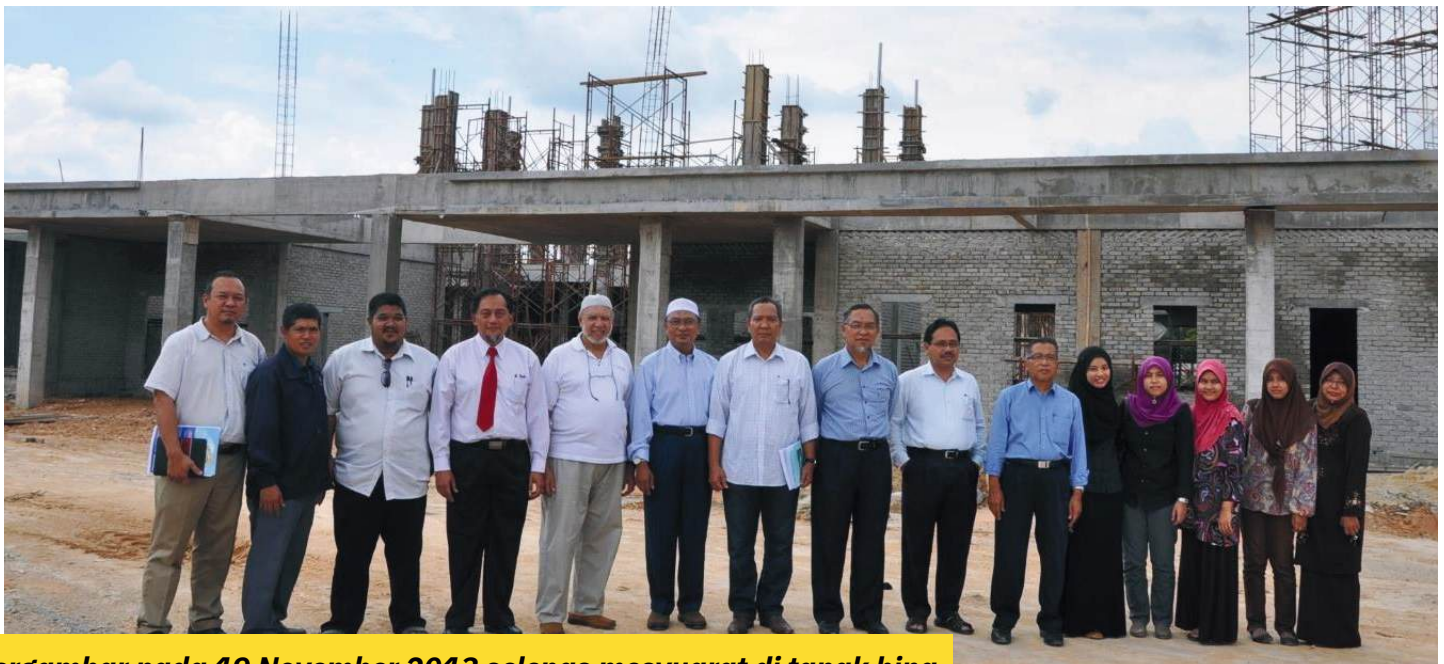
Bergambar pada 19 November 2013 selepas mesyuarat di tapak bina.
