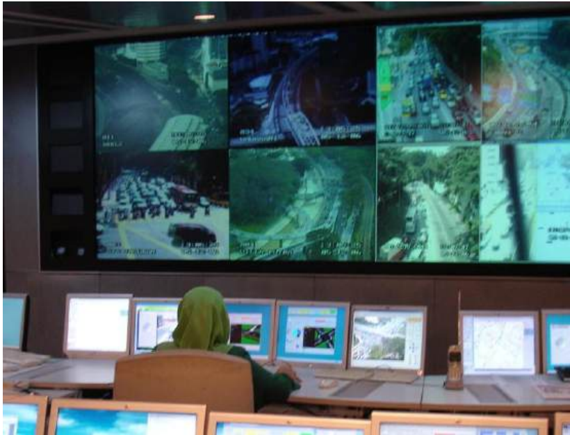
Bilik Kawalan Lalu Lintas Kuala Lumpur
